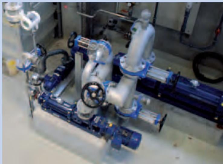
In der Polymeransatzstation wird das Polymerwassergemisch, das dem Klärschlamm vor der Verarbeitung in der Zentrifuge zugesetzt wird, hergestellt.
